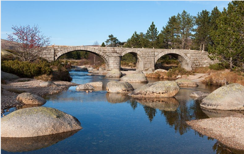
Le pont du Tarn (© Guy Grégoire)
