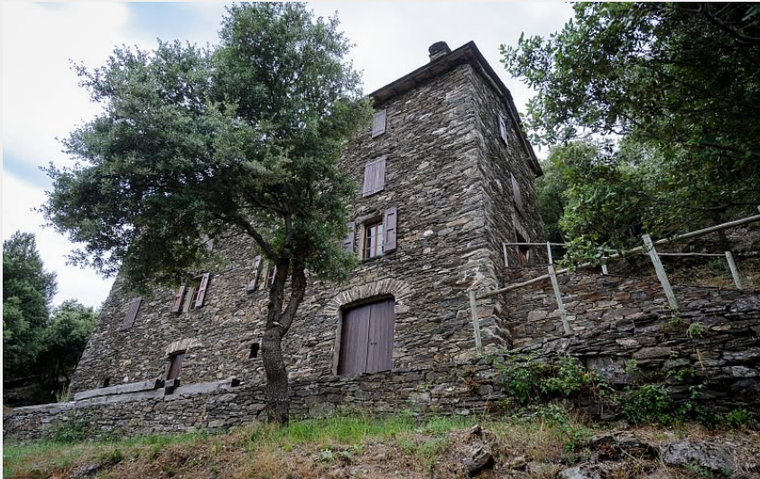
Magnanerie de La Roque (© A. Bouissou/TERRA)
