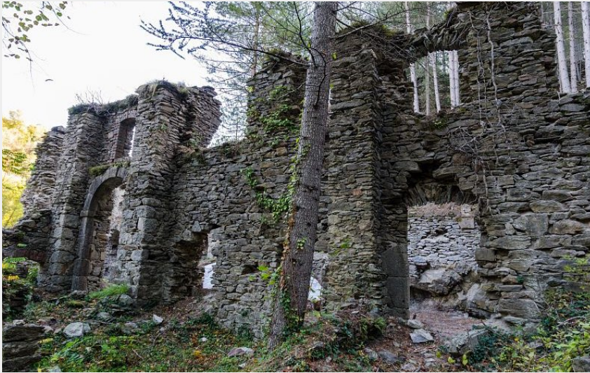
Usine du Bocard (© Olivier Prohin)
