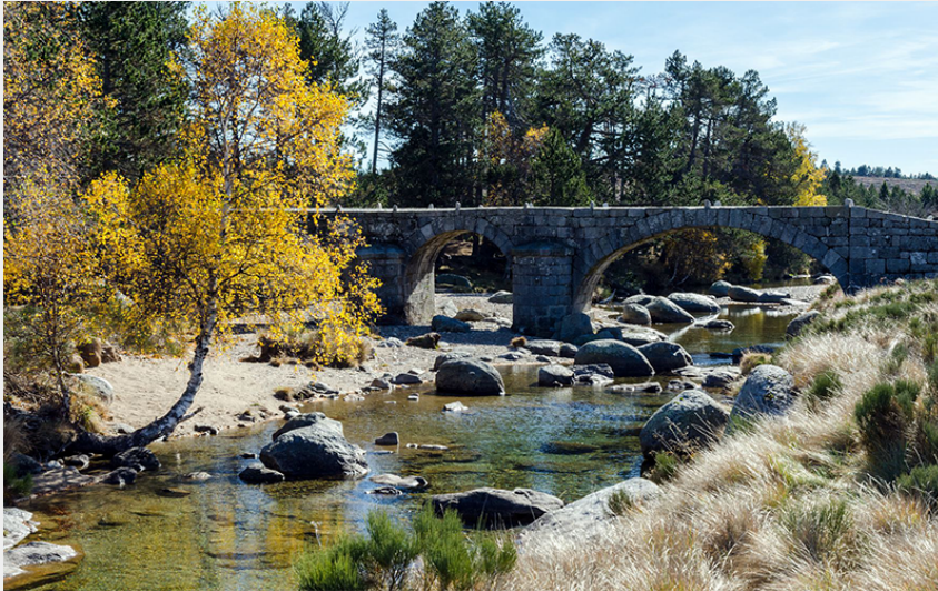
Pont du Tarn (© Olivier Prohin)
