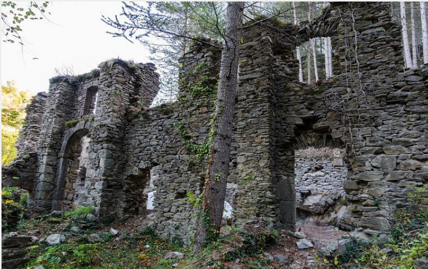
Usine du Bocard (© Olivier Prohin)
