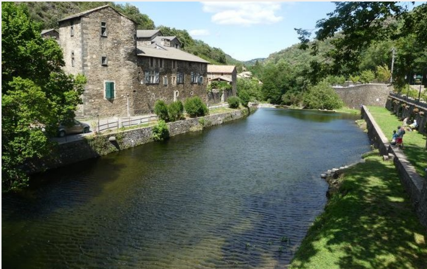
Le château des Plantiers (N. Thomas)
